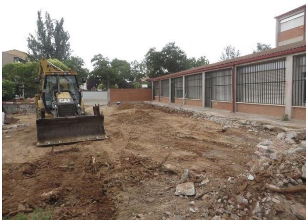
Desarrollo de las obras
